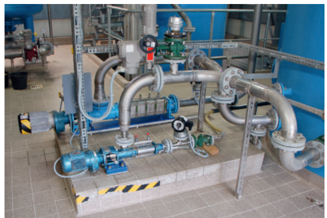
Exzentrerschneckenpumpe: Dosierung und Umwälzung
