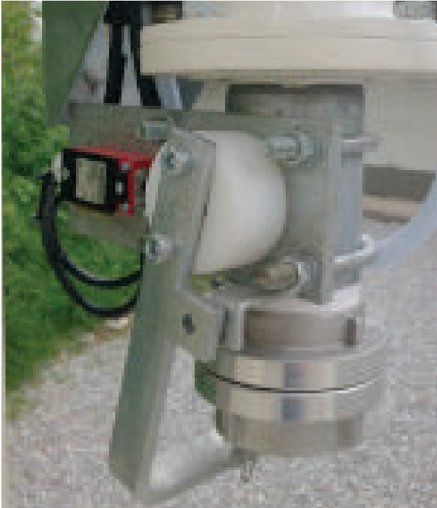
Befüll-Kupplung (Storz) für Schüttgüter und pneumat. Verschluss zur Überfüllsicherung
