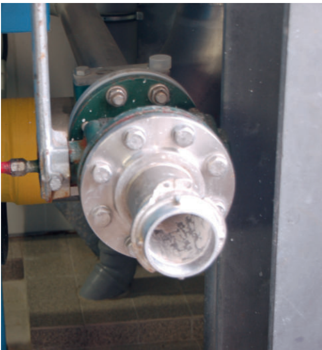
Unzweckmäßige Aufweitung der Füllleitung
