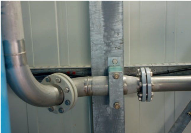
Unzweckmäßige Aufweitung der Füllleitung
