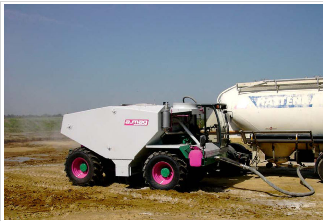
Bild 11.2: Kalkübergabe von Silofahrzeug in den Verteiler
