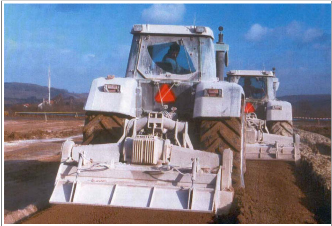
Bild 11.8: Einfräsen des Kalkes - Staffelung von 2 Anhängефräsen
