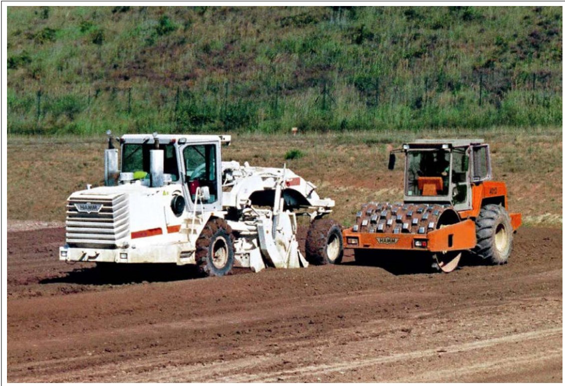
Bild 11.10: Einfräsen des Kalkes und verdichten des Boden-Kalkgemisches
