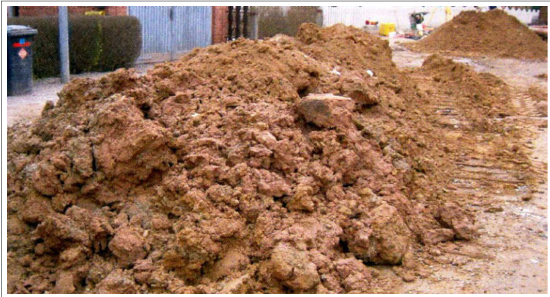
Bild 11.12: Kanalaushub vor der Behandlung mit Kalk
