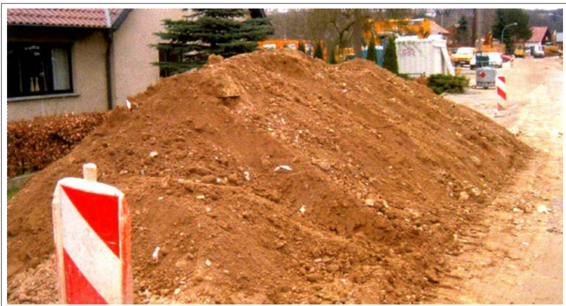
Bild 11.13: Kanalaushub nach der Behandlung mit Kalk
