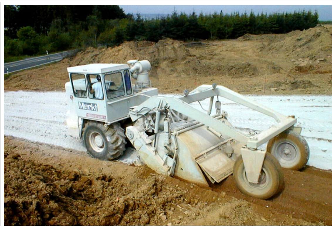
Bild 11.7: Einfräsen des Kalkes
