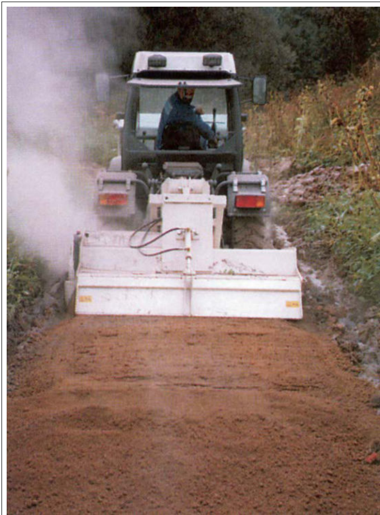
Bild 11.8: Einfräsen des Kalkes - Staffelung von 2 Anhängефräsen
