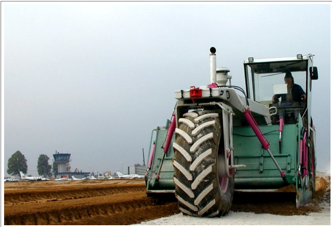
Bild 11.6: Einfräsen des Kalkes
