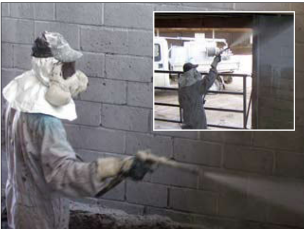
Abb. 5 Beispiel für das Tünchen eines Stalls mit Kalkmilch. Kalkmilch kann auch mit einer Bürste oder mithilfe einer anderen geeigneten Technik aufgetragen werden (Belgien)
