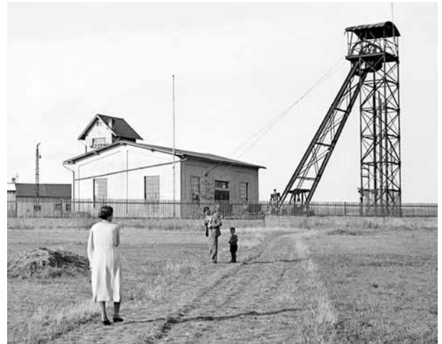
Übertägige Anlage mit Fördergerüst in den 1960er-Jahren
