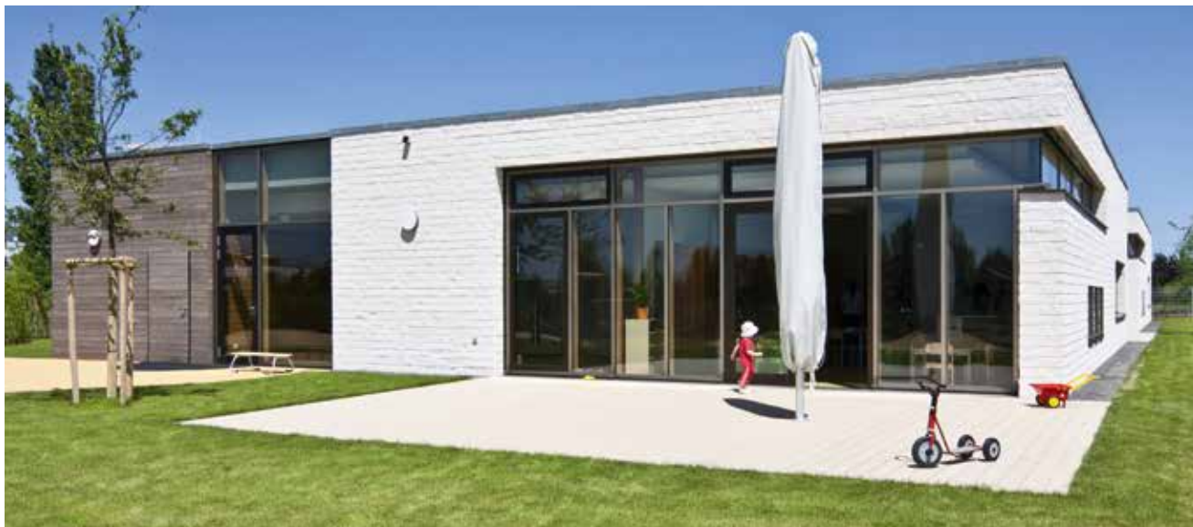
Kalksandsteinhaus – Quelle: Stefan Witte
